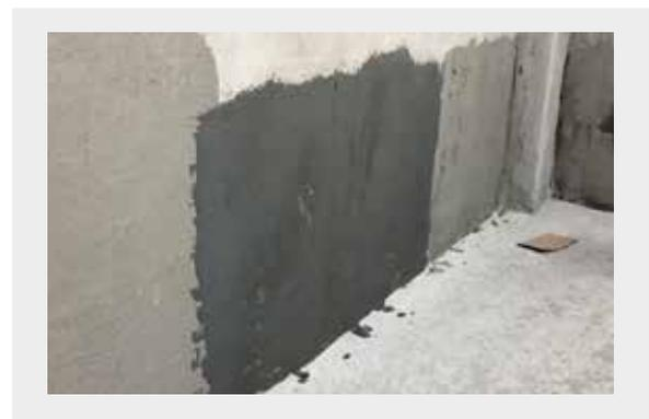
3.3 Após a execução em toda área, aguardar 24 horas e aplicar mais duas demão do **bsPRESSURE**, só que desta vez, no processo normal, a frio, conforme o procedimento de aplicação.
